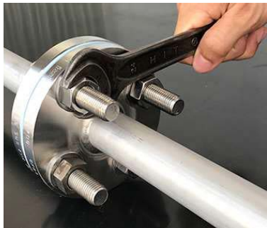
フランジをボルトで固定
